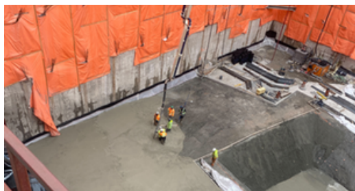
(Figure 2): Concrete pour and waterproofing system
